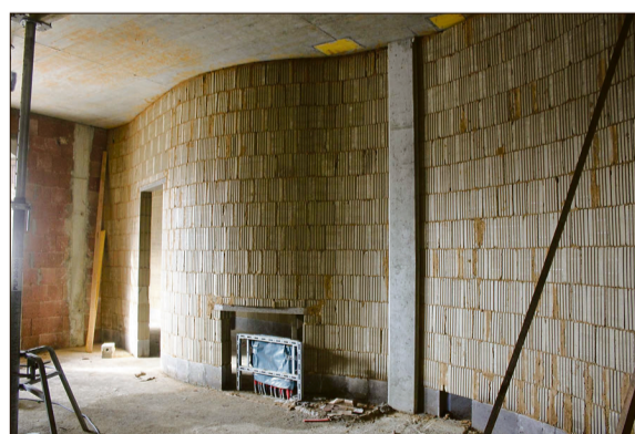
Innovative Verfahren: Ein Großteil der Wände des Schulneubaus besteht aus ungebrannten Lehmsteinen. Foto: Thomas Glaubitz
